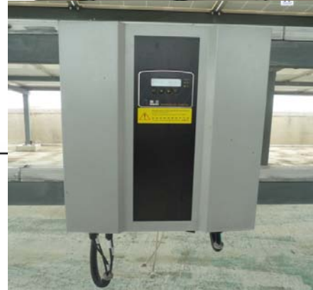
PV inverter (EnerSolis 12KW)
